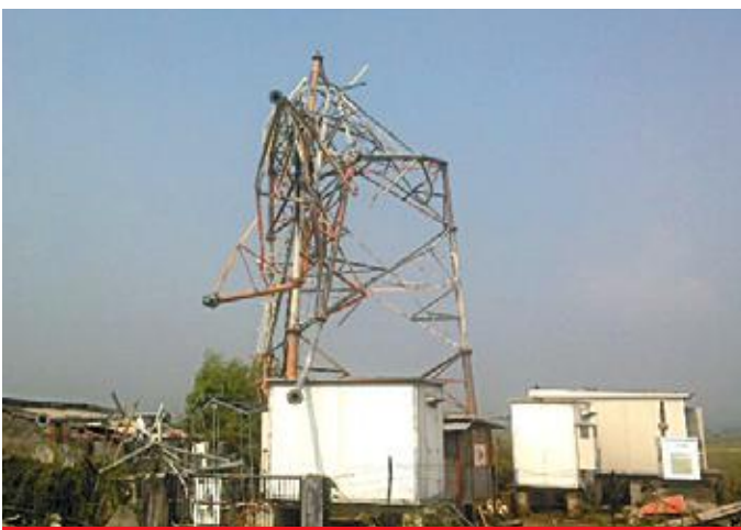
Site de tour de télécommunications de Balipadar à Odisha après l'effondrement (ci-dessus) et après la réhabilitation (ci-dessous)
